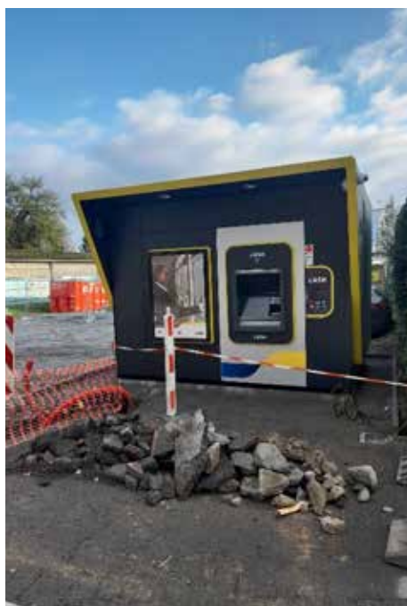
Installation d'un distributeur de billet par l'entreprise Batopin sur le parking du hall des sports à Gesves
