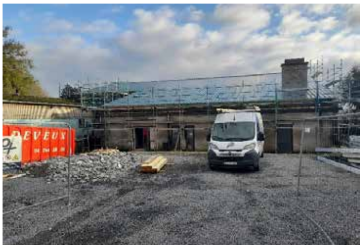
Remplacement de la toiture du hall des sports
