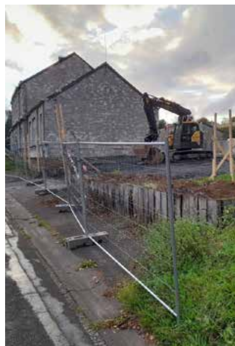
Démarrage des travaux de la nouvelle implantation scolaire à Mozet
