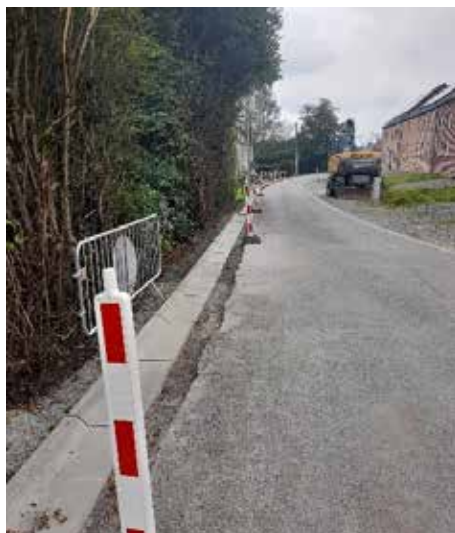
Poursuite de la pose de filets d'eau dans les zones inondables
