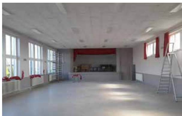
Rénovation de la salle des fêtes de la maison communale
