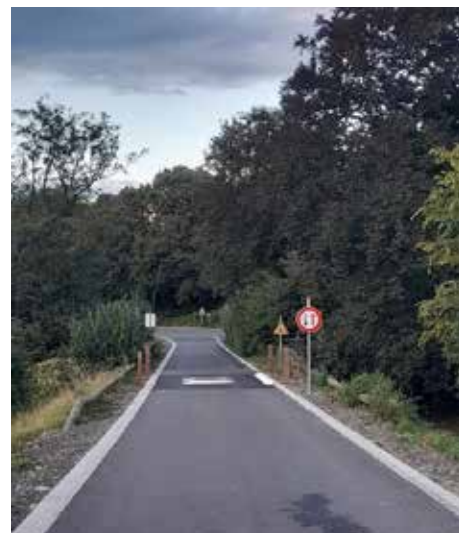
Aménagements de sécurité routière et réfection de la rue de Strud/route d'Andenne
