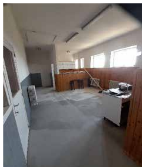
Rénovation de la buvette du club de Tennis de table de Gesves
