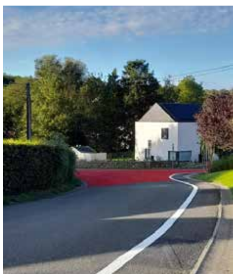
Aménagement du Baty Pire à Gesves pour la traversée du ViciGAL
