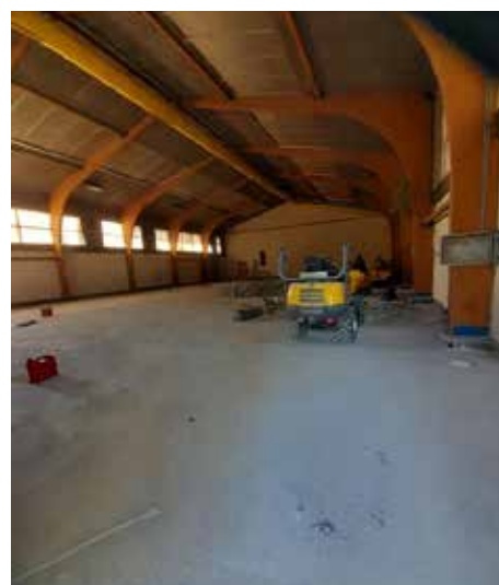
Début des travaux de rénovation du hall omnisports
