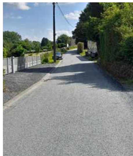
Réfection de la ruelle Burton à Gesves dans le cadre du ViciGAL
