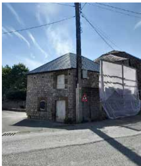
Poursuite de la rénovation de l'ancienne forge de Strud
