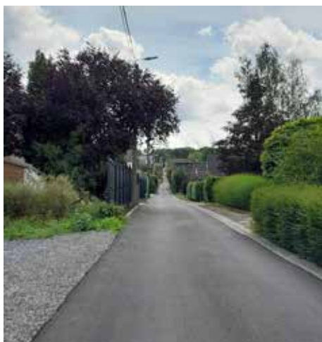
Remplacement de la conduite d'eau rue de la Pologne à Faulx-Les Tombes et du revêtement de la voirie
