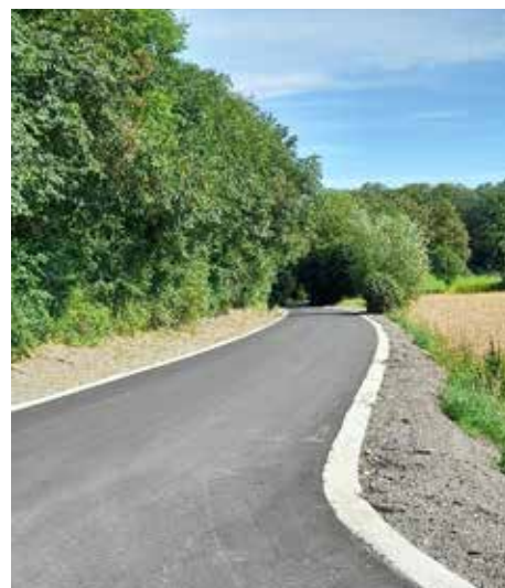
Rénovation de la route d'Andenne/rue de Strud
