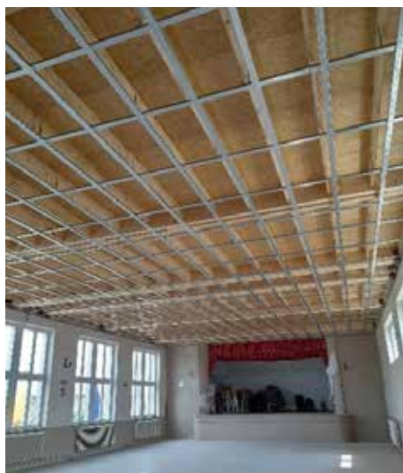
Poursuite des travaux du remplacement de la charpente et du plafond de la salle des fêtes de la maison communale
