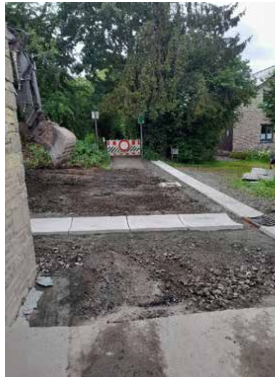
Finalisation du Vicigal : travaux de voirie ruelle Burton à Gesves
