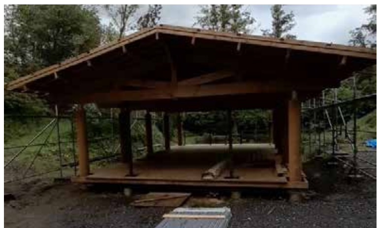
Poursuite du chantier de construction du chalet de la « maison de la nature » à la Pichelotte
