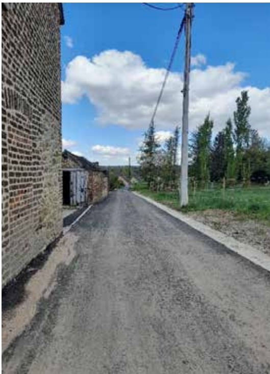
Réfection complète de la voirie à l'impasse des Merles à Faulx-Les Tombes
