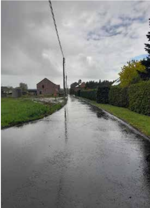
Réfection complète de l'impasse des Mésange à Faulx-Les Tombes
