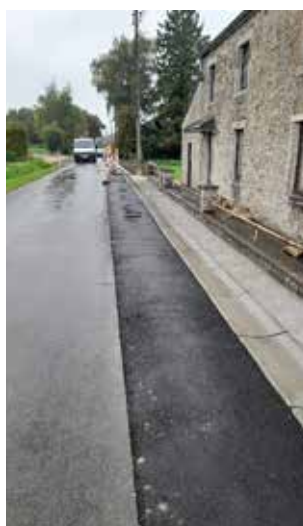
Pose de filets d'eau, aménagement d'accotements et réparation d'un pont
