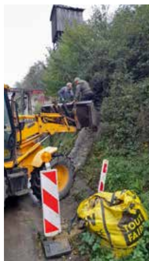
Réparation de murs aux anciennes carrières à Gesves
