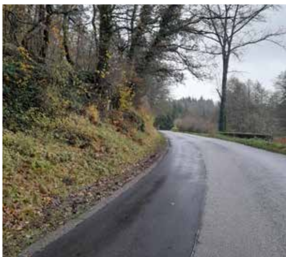
Travaux d'entretien de voirie au Pourrain et à la rue des Carrières à Gesves
