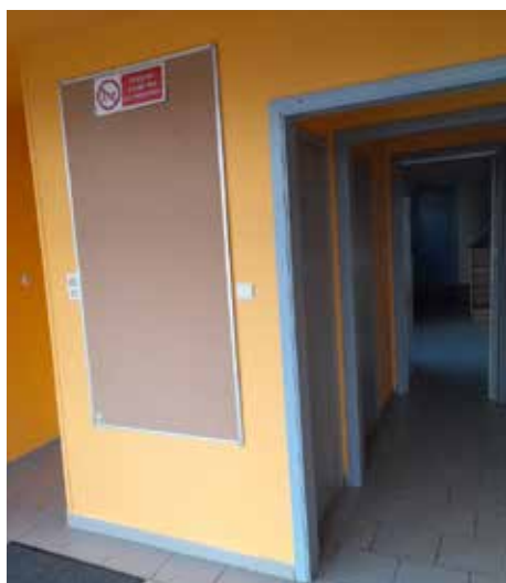
Travaux de peinture à la salle communale de Haut-Bois
