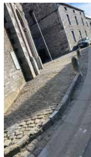
Entretien du parvis de l'église de Gesves
